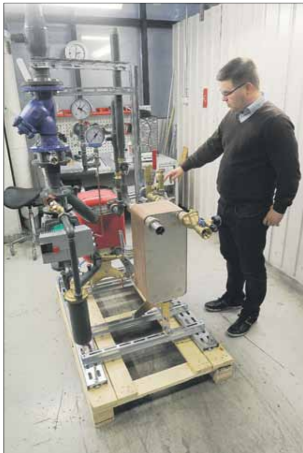
Lämmönjakokeskukset pyritään tekemään Antti Hartmanin mukaan mahdollisimman helpoiksi asentaa.
